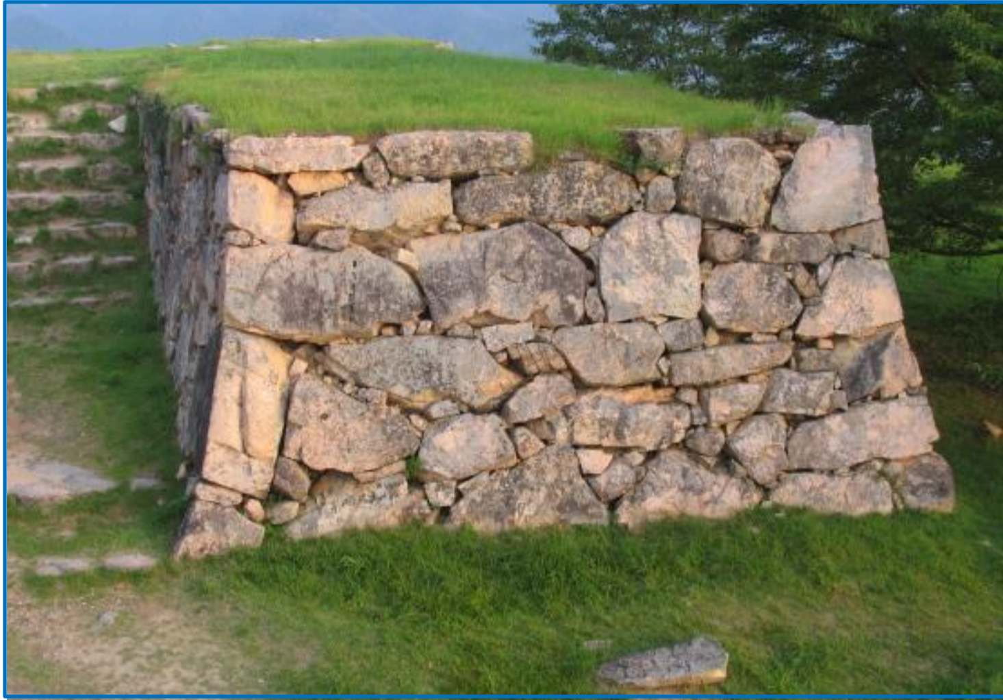
穴太積みで積まれた天空の城・竹田城の石垣
